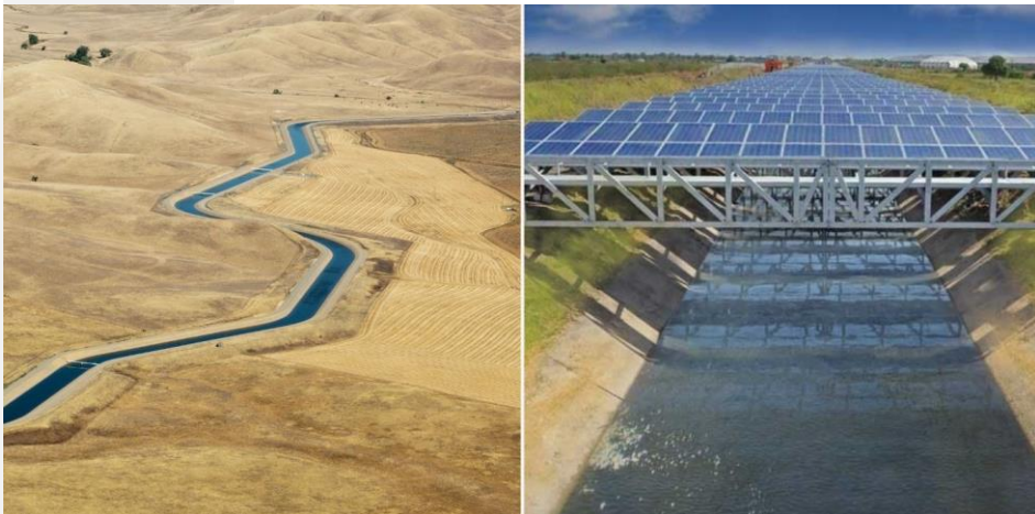
Gambar 4.3 Ilustrasi Desain PLTS Diatas Saluran Irigasi Sebagai Solusi Evaporasi Air Irigasi dan Efisiensi Produksi Listrik PLTS.
